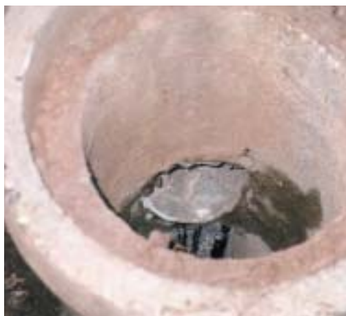
Regnvandsfaldstammer Renovering af regnvandsfaldstammer med strømpe-metoden på Århus Universitet 1999
