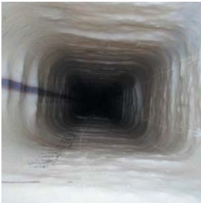
Skorsten Renoveret med strømpe- metoden
