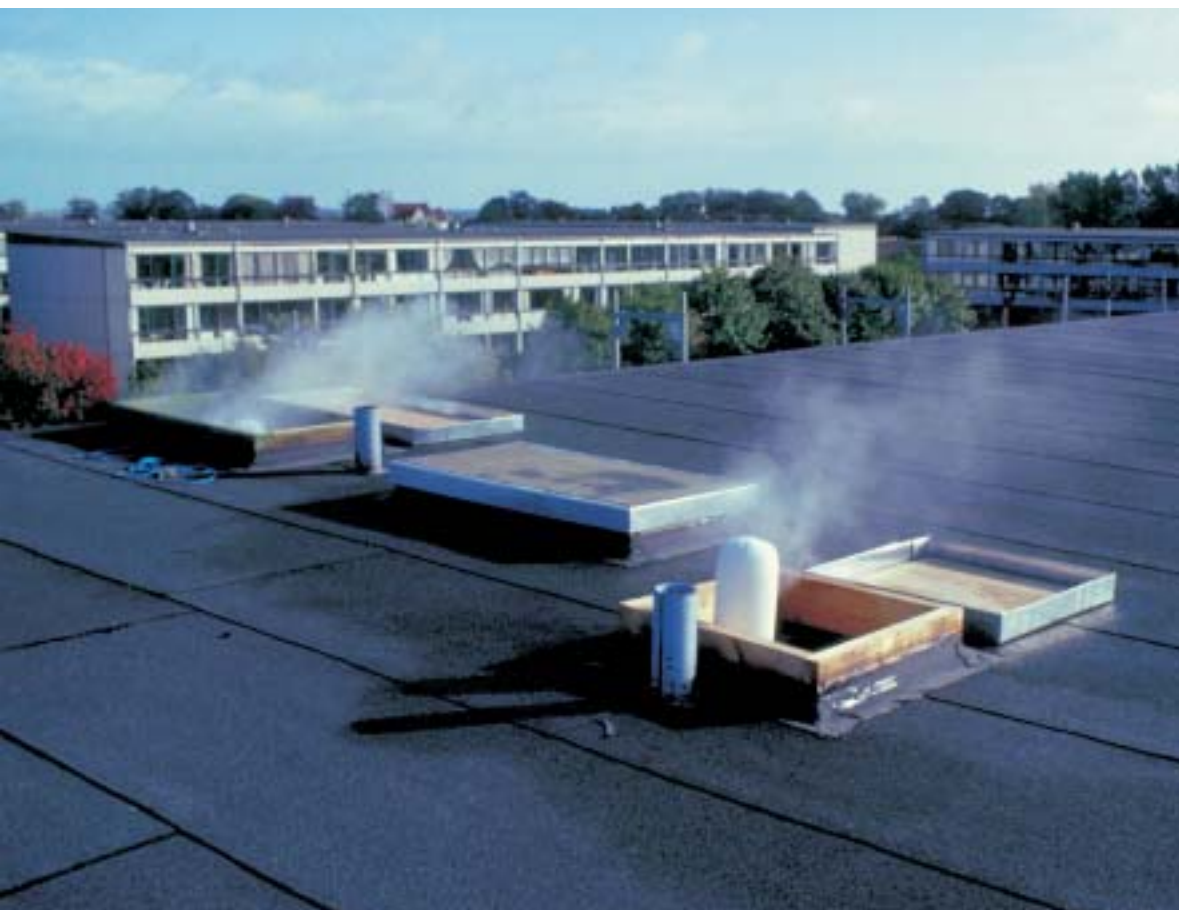
Ventilationskanaler Lodrette ventilationskanaler renoveres med strøp- metoden
