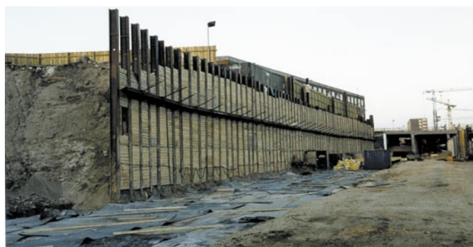
Øresund landanlæg - Tårnby overdækningen.
