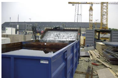
Grundvandssænkning Dokøen, Nyt Operahus Iltningstrappe samt 20' sedimentationscontainer (se skitse på bagsiden).
