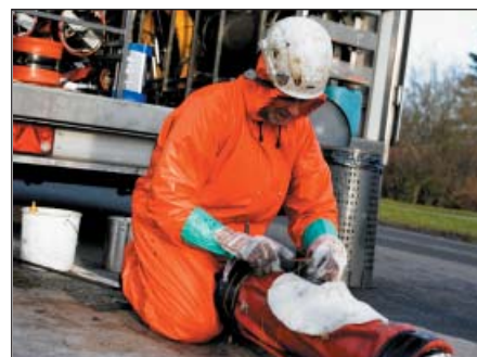
Stikledningerne blev renoveret med Aarsleff Hatprofil.
